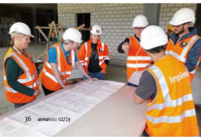
Die armasuisse Mitarbeitenden bei der Baustellenbesichtigung.
