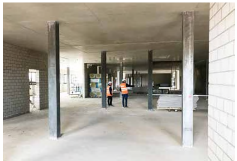
Die Räumlichkeiten von armasuisse im Rohbau.
