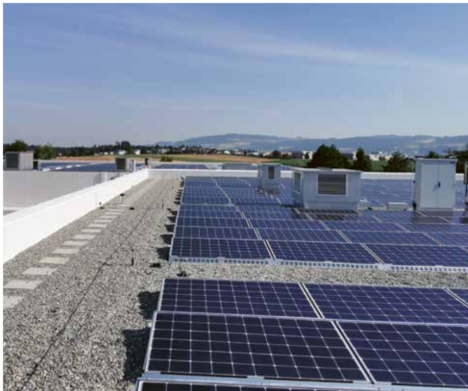
Auf insgesamt 6000 m 2 tragen Photovoltaikmodule zur Stromversorgung des Campus bei. (Bild: Campus Sursee)
